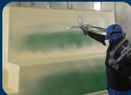
2 Gelcoatage du moule
