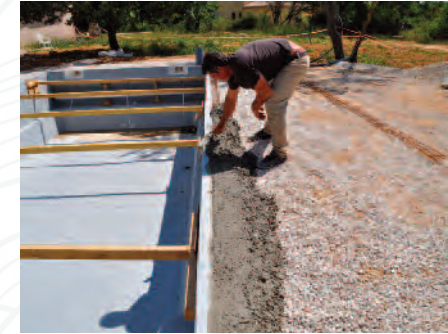
8 Etayage et ceinture béton armé
