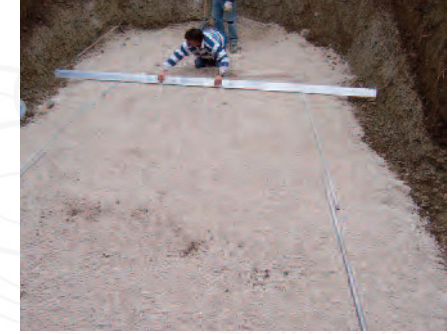
4 Préparation du sol - Radier
